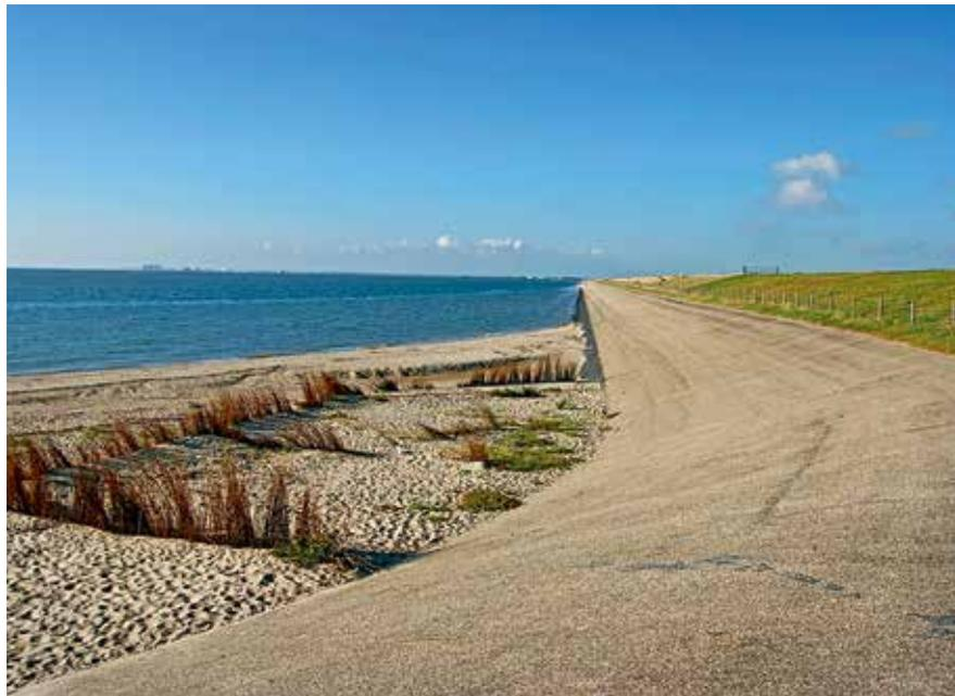
Abbildung 20: Vor diesem Asphaltdeich sieht eine der Planungsvarianten für dessen Verstärkung die Aufspülung eines Dünenstreifens sowie die Schaffung einer vorgelagerten Salzwiese vor.
